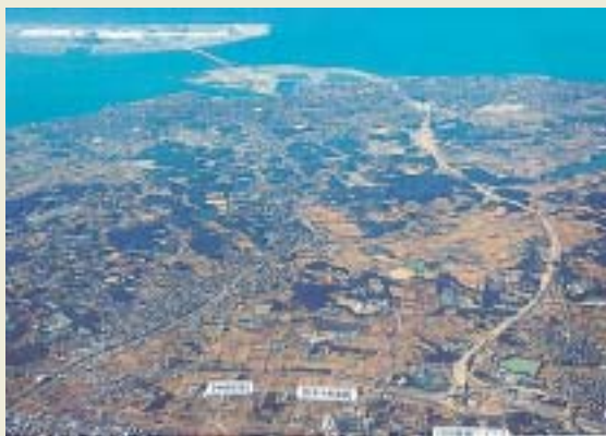
知多横断道路建設中
